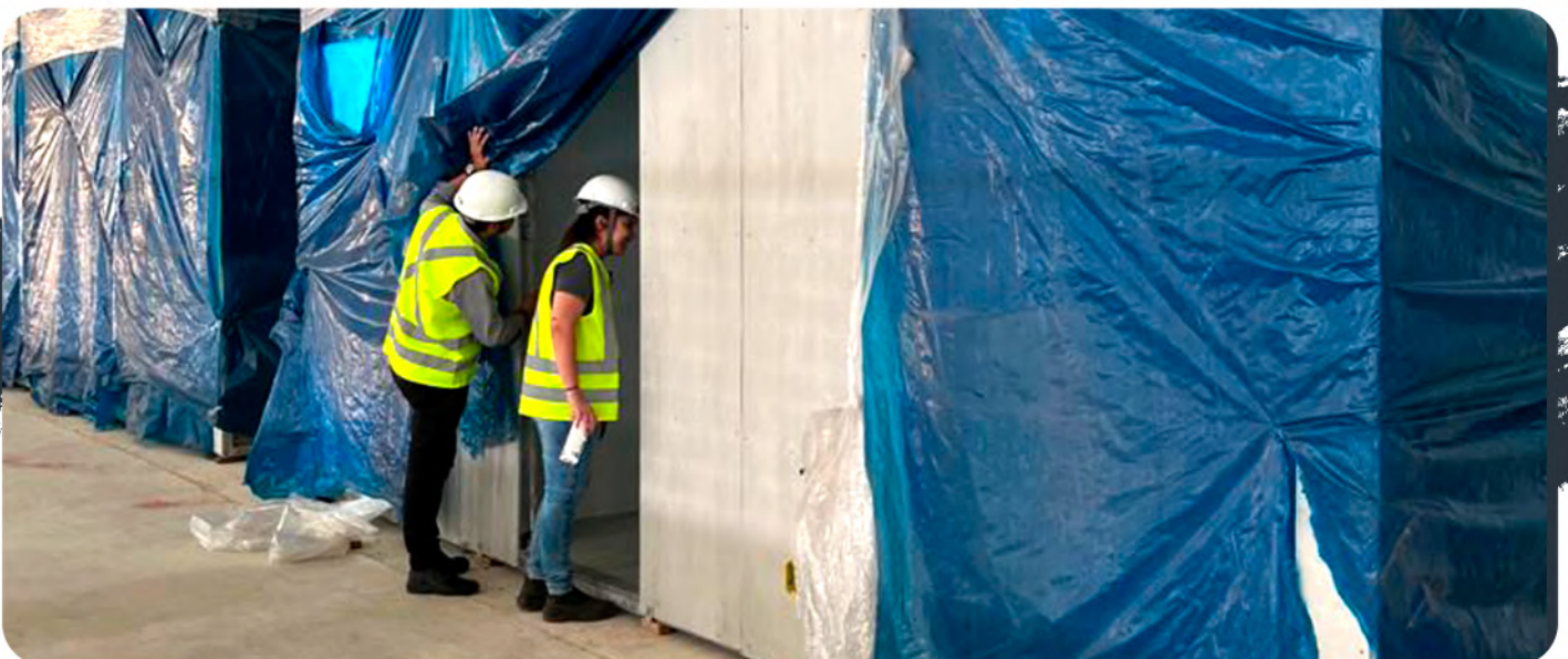
Equipe Matec Inspeccionando os Módulos Sanitários
