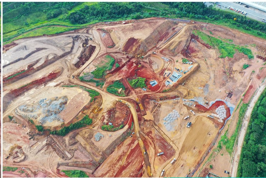
FOTO: OBRA HSI SYSLOG CAJAMAR
