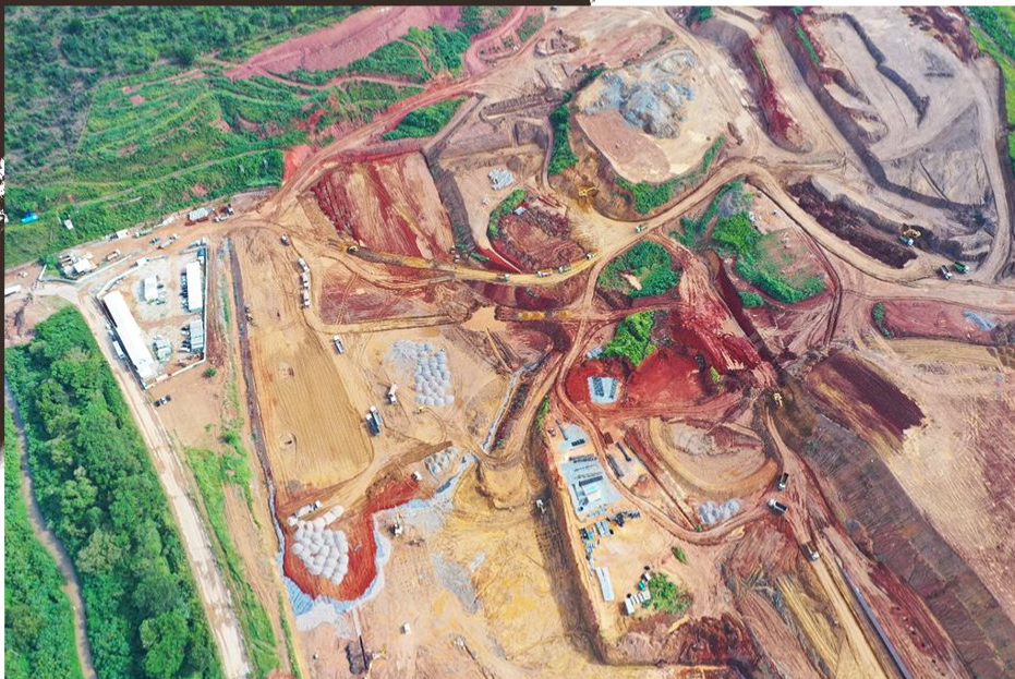
FOTO: OBRA HSI SYSLOG CAJAMAR
